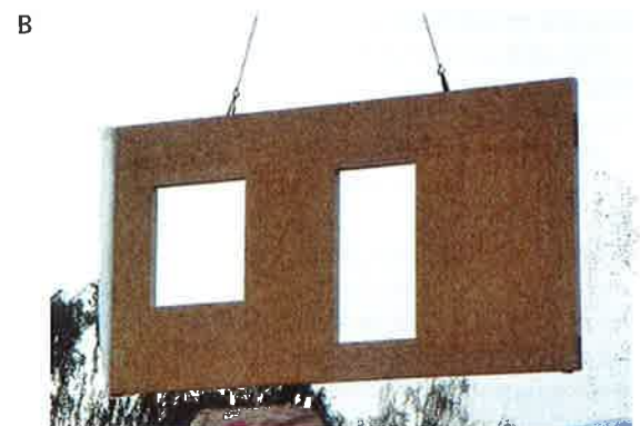
Abb. 1: Bestandssanierung Mehrparteienhäuser zum Passivhaus-Standard, Frankfurt am Main, Büro Faktor 10 GmbH [Faktor_10 2010] A: Gebäude vor und nach der Sanierung B: Errichtung des Staffelgeschosses mit vorgefertigten Holzrahmen-Elementen
